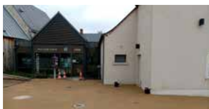
Accès de la mairie de Charentilly
