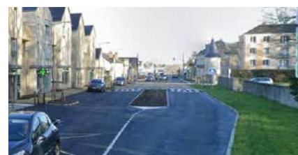
Aménagement de l'avenue du Gal de Gaulle à Neuillé-Pont-Pierre
