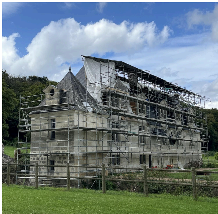
Le Manoir pendant les travaux. photo fournie par Frédéric Amiot
